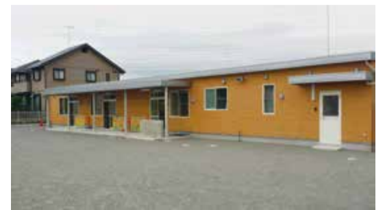
中新田保育園西棟
